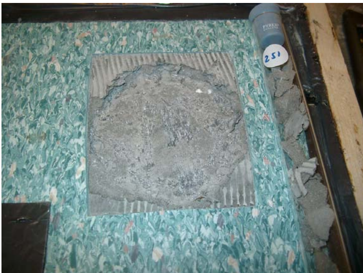
Bild: Uttag av fuktprov på nivån 0-10 mm. Provet är lagt i provrör för RF-bestämning.
